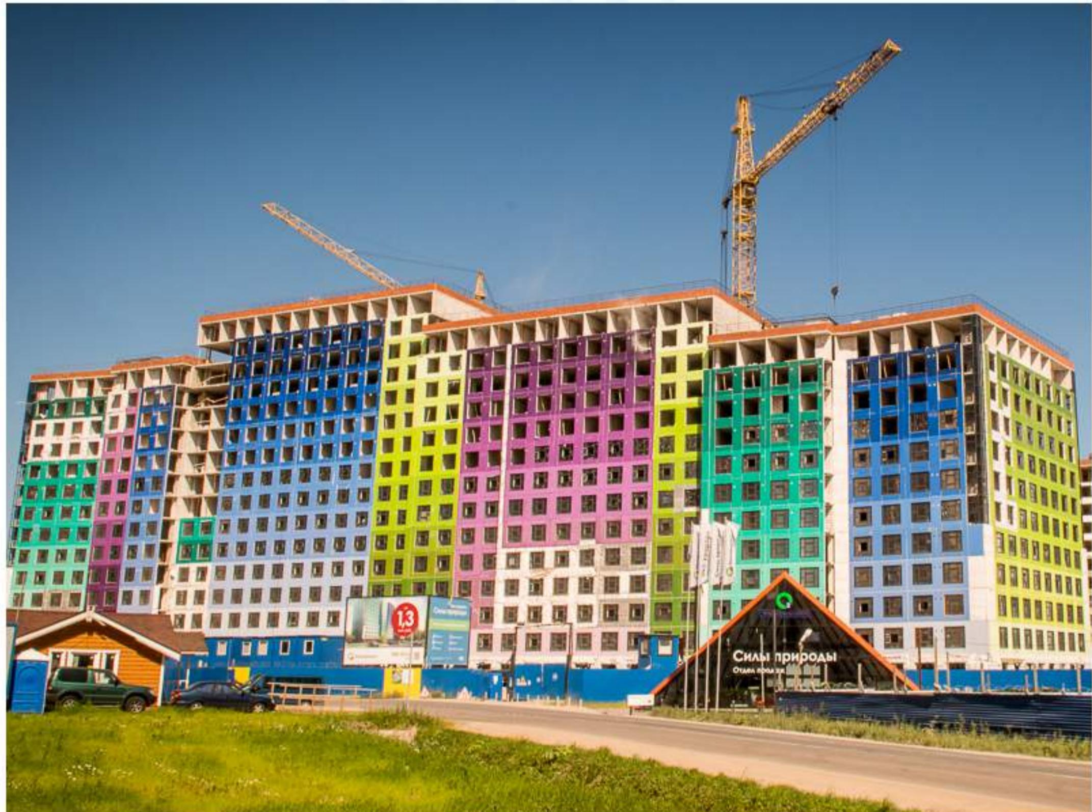
Технология возведения наружных стен МЕТТЭМ может быть применена при монолитном, сборном железобетонном и металлическом каркасе здания. В таких конструкциях внутренние перегородки могут быть возведены в любом месте, что позволяет создавать различные планировочные решения, кардинально отличающиеся на смежных этажах.
